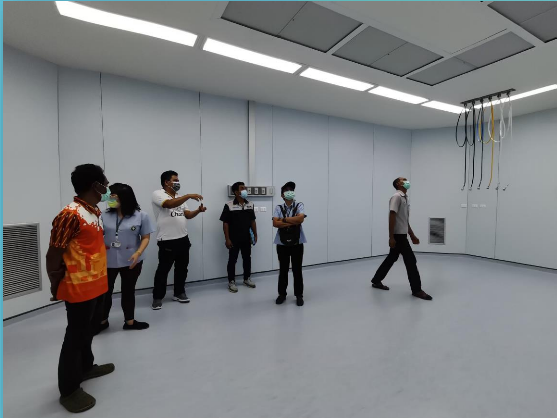
ปรับปรุงระบบระบายอากาศห้องผ่าตัด ER ใหม่ ชั้น 4 จำนวน 3 ห้อง
